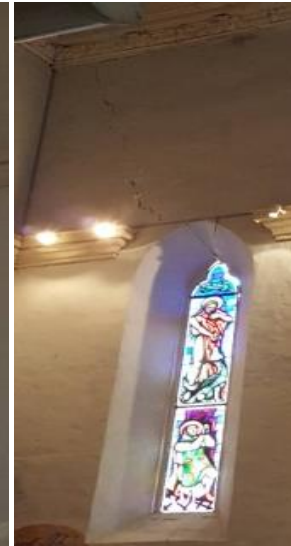
Lesioni passanti monofore – vista interna
