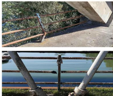
PARAPETTO METALLICO - Elementi ammorlati ed ossidati con lesioni sulle giunzioni; - Lesioni gravi degli elementi in corrispondenza del 4° strallo lato Campania (causate dall'incidente del 2019); I parapetti metallici presentano uno stato di degrado avanzato con ossidazione completa degli elementi e lesioni di vario genere che ne inficiano la corretta funzionalità.
