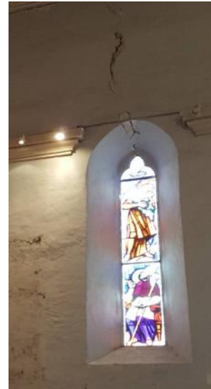
Lesioni passanti monofore – vista interna
