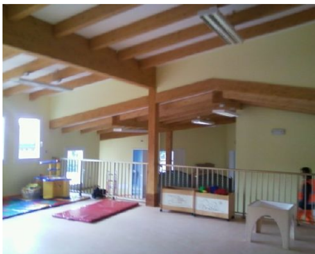
Foto 5.4: Interno di una scuola.
