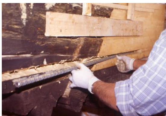
Inserimento della barra di acciaio.
