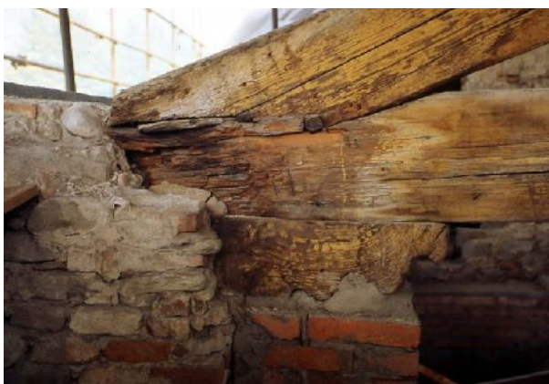
Vista della testata prima dell'intervento
