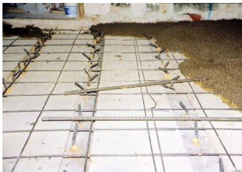
Solaio a singola orditura con connettori del tipo "Turrini-Piazza" (barre di acciaio da c.a. fissate nel legno con malta epossidica)
