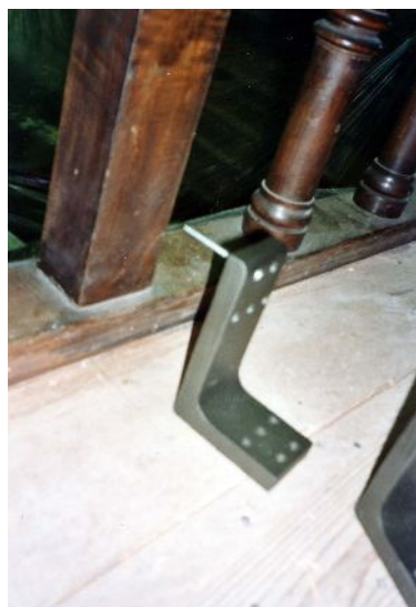
Vista di un lato del ballatoio. Particolare della squadretta metallica di rinforzo prima della messa in opera. Vista del giunto consolidato.
