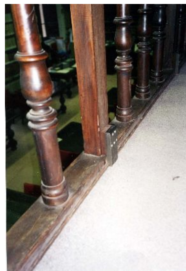
Vista di un lato del ballatoio. Particolare della squadretta metallica di rinforzo prima della messa in opera. Vista del giunto consolidato.
