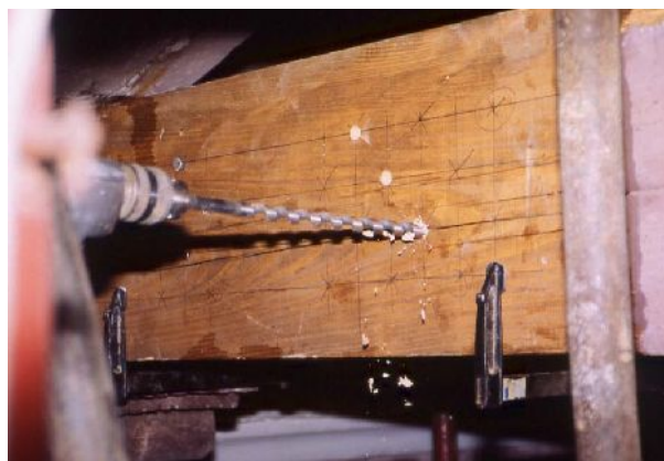
Foratura per l'alloggiamento degli spinotti e delle barre filettate
