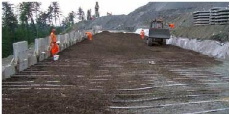
Autostrada A1 Variante di Valico: Rilevati leggeri in "Terra Armata"
