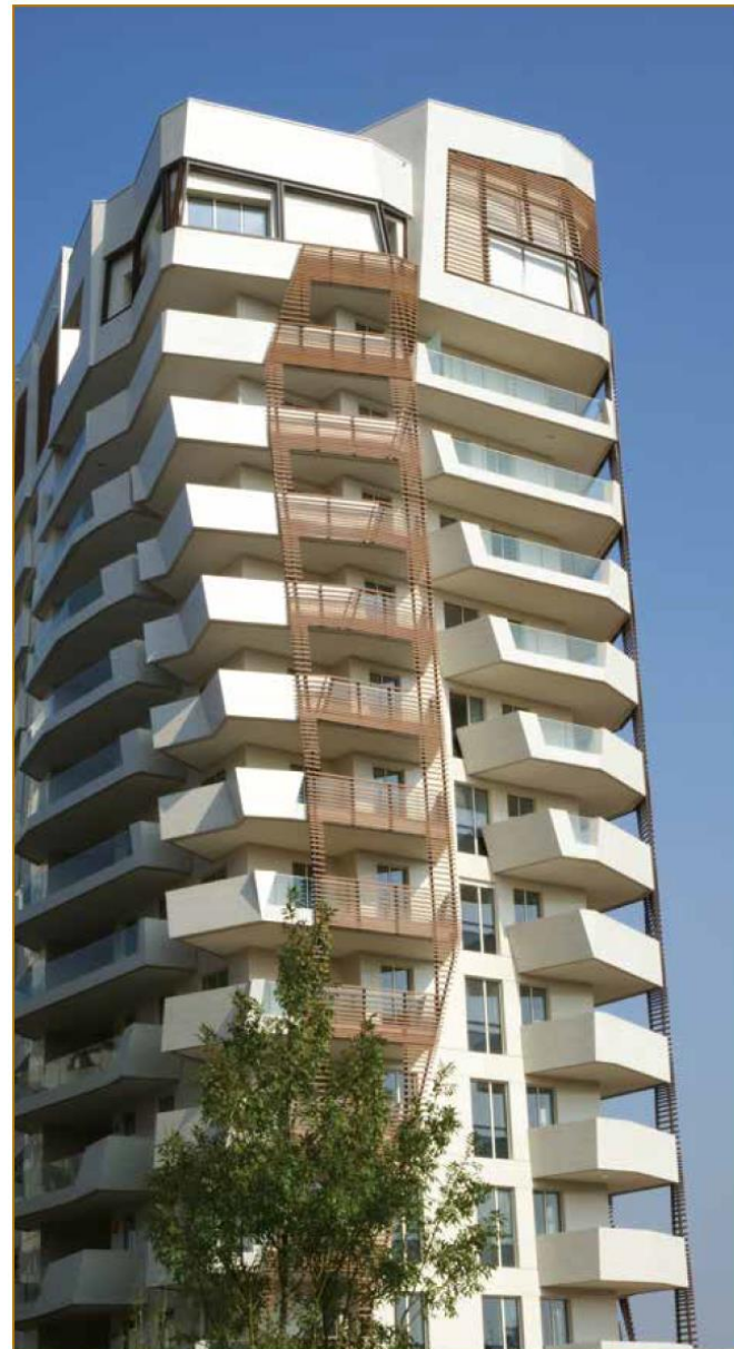
Edificio pluripiano con elementi in aggetto (parapetti) e struttura portante di sommità (piano attico e superattico) in calcestruzzo leggero strutturale (CityLife Milano).
