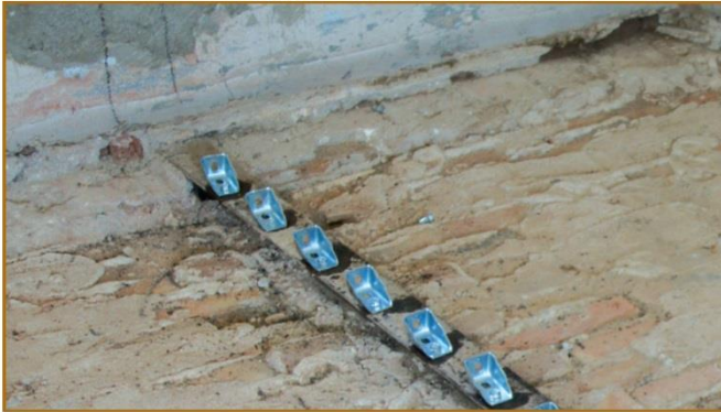
Connettore non industrializzato (tipo sistema "Turrini-Piazza")
