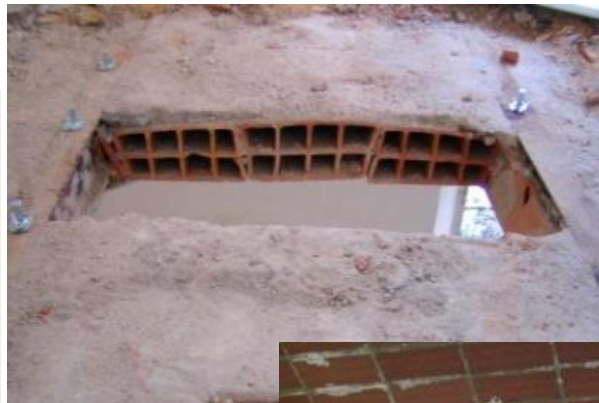
Singolo tavellone con cappa in calcestruzzo.
