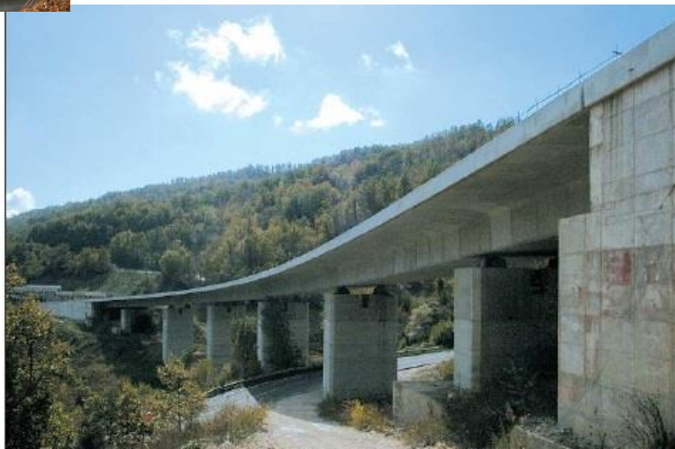
Viadotto S.S. Isernia Castel di Sangro (AQ)
