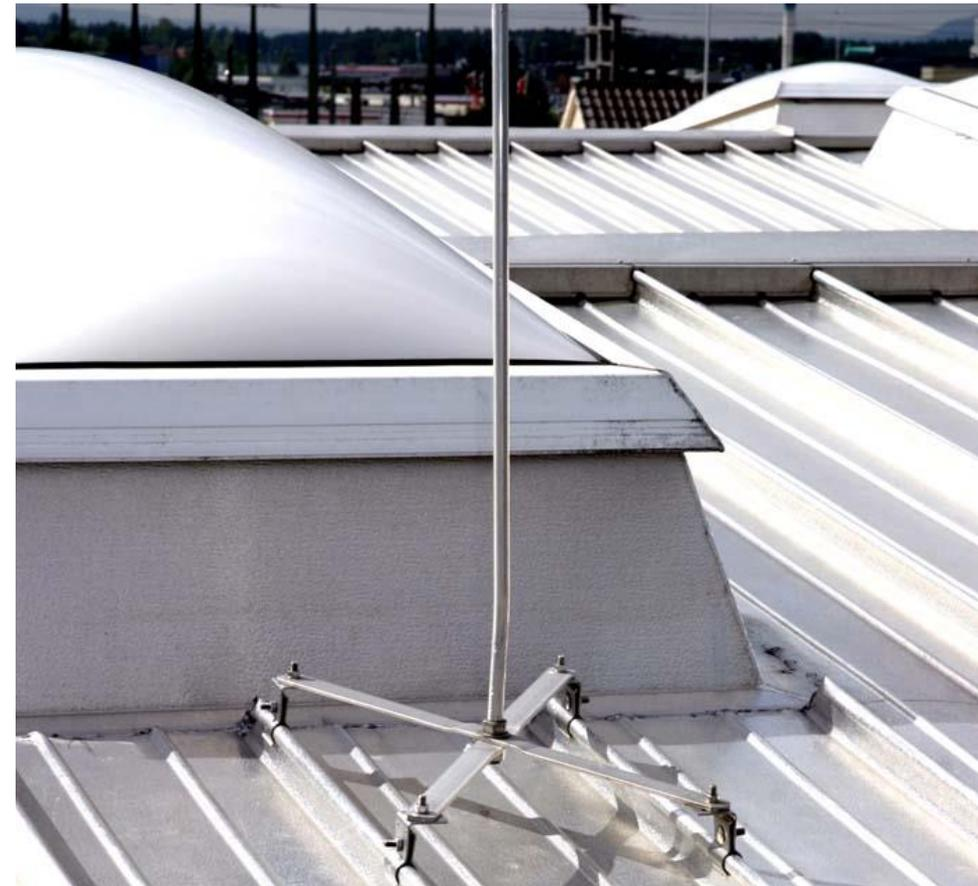
In caso di utilizzo di quattro morsetti, la capacità di carico della corrente da fulmine è data fino a 100kA (10/350 $\mu$ s)
