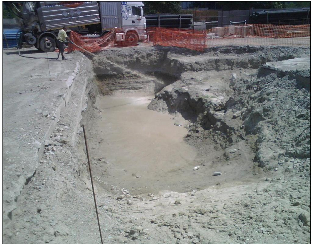
Immissione della miscela nello scavo mediante autospurgo
