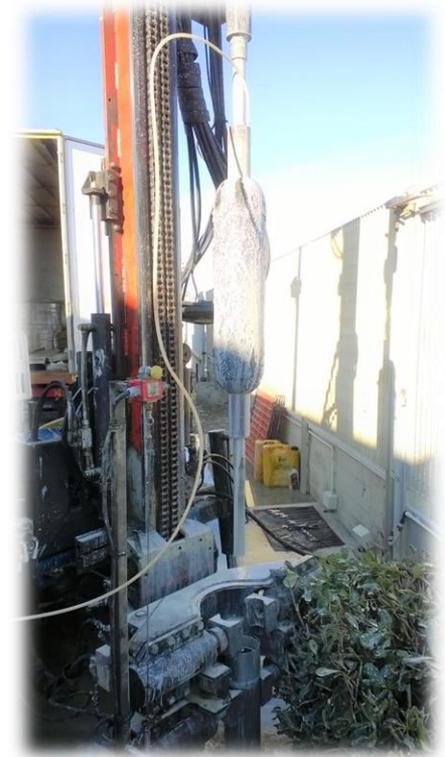
Immissione della miscela in foro mediante perforatrice idraulica
