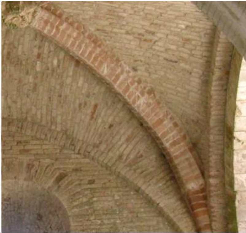
Costolature laterizie diagonali nelle volte laterizie a crociera della chiesa di San Galgano (Siena) (Foto F.Masseti)
