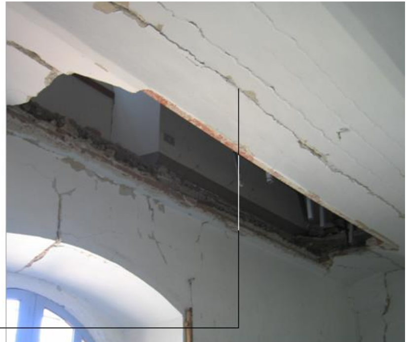
Tipica configurazione di dissesto di solai a voltine laterizie su travi di acciaio, con quadro fessurativo e collassi parziali.
