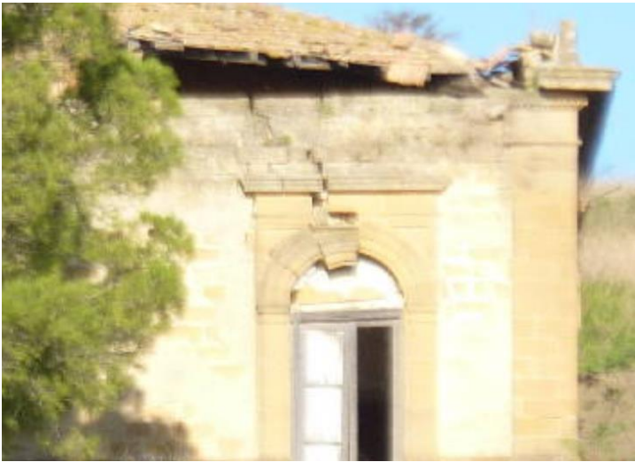
ALLONTANAMENTO DELLE IMPOSTE E SCORRIMENTO DEI CONCI
